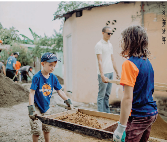
Nolan Klassen (à gauche) et Isaiah Wong sont en train de tamiser du sable pour le béton des murs d'une maison à l'épreuve des ouragans dans le cadre d'un projet Shine the Light en République dominicaine. Pour ses projets, Shine the Light fait appel à des bénévoles de tous âges.
